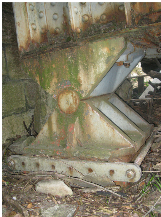
Figura 2. Apoyo deslizante del mismo puente.
