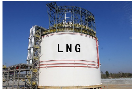
Fig. 1. LNG storage tank [3]
