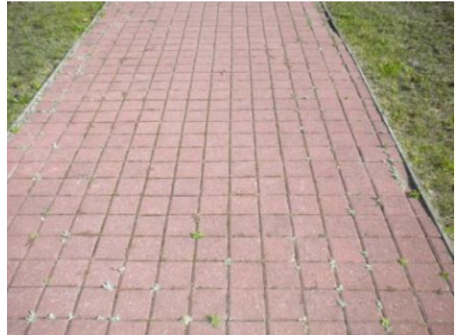
Figure 1. Chemin de dalles.
