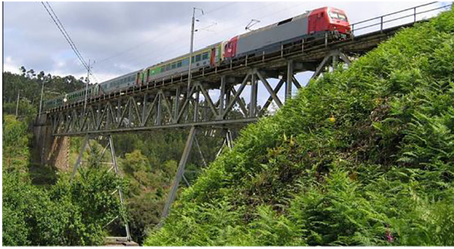
Fig. 1. The Trezói Bridge.
