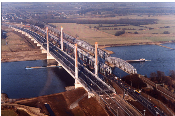
Fig. 1. Martinus Nijhoff Bridge.
