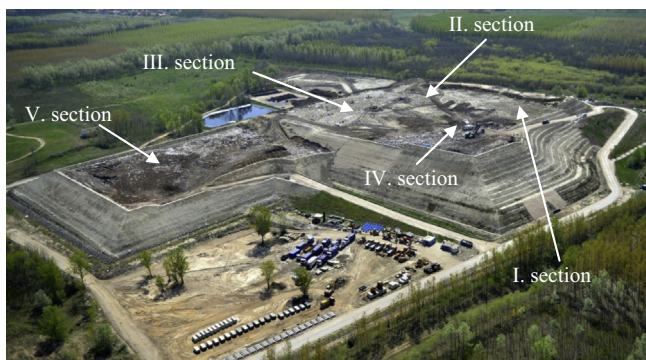
Fig. 1. The municipal waste landfill in Gyál.
