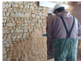
(d) Spraying ( 200 - 500 \text{ kg}\cdot\text{m}^{-3} ).
