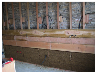
(c) Shuttering ( 200 - 500 \text{ kg}\cdot\text{m}^{-3} ).
