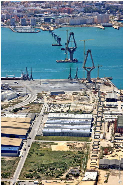
Figura 3. Vista general de pilas.
