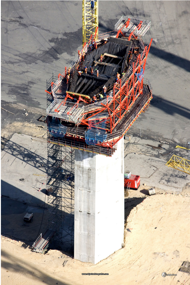
Figura 1. Fuste de la torre P13 ya construido al cambiar el proceso constructivo.
