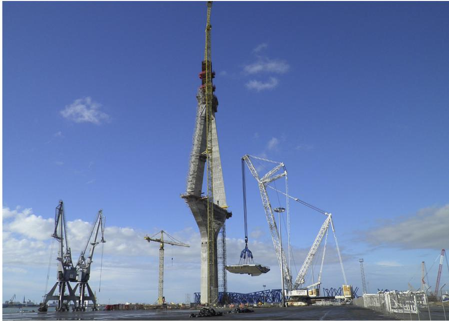
Figura 1. Izado de la dovela «0» de la pila 13.
