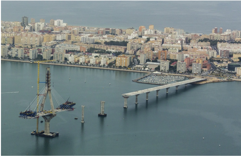
Figura 1. Vista general del tramo empujado.
