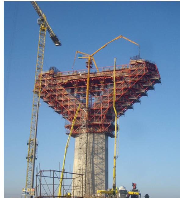
Figura 3. Hormigonado de riostra de torre 13.
