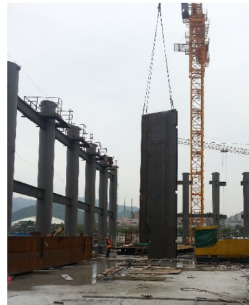
(d) Hoisting of composite shear wall
