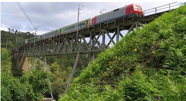
Fig. 1. The Trezói bridge.
