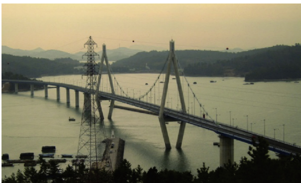
Fig. 1. The Sorok Bridge.
