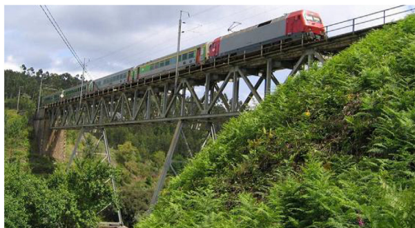
Fig. 1. The Trezói bridge.
