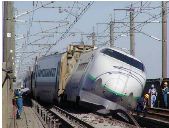
Fig. 1. Derailment of Japan Shinkansen.
