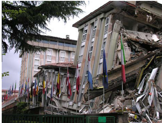
Fig. 1. Collapse of part of the Duca D'Abruzzi Hotel, L'Aquila, 2009 [1].
