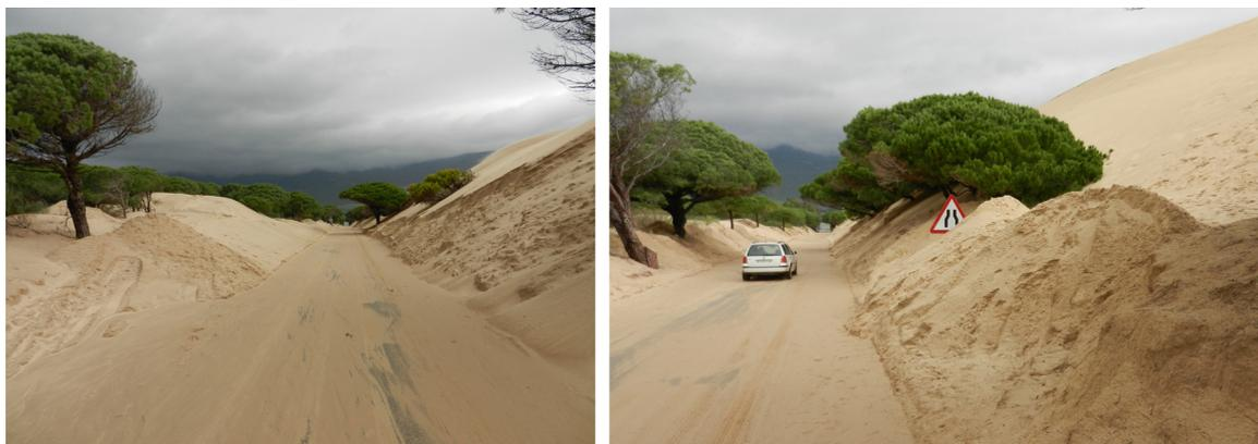
**Figura 2.** Carretera A-2325 el 7 de diciembre de 2012. El pavimento de la vía se encuentra cubierto de arena procedente de la duna, que ha sepultado señales de tráfico y vegetación arbórea.
